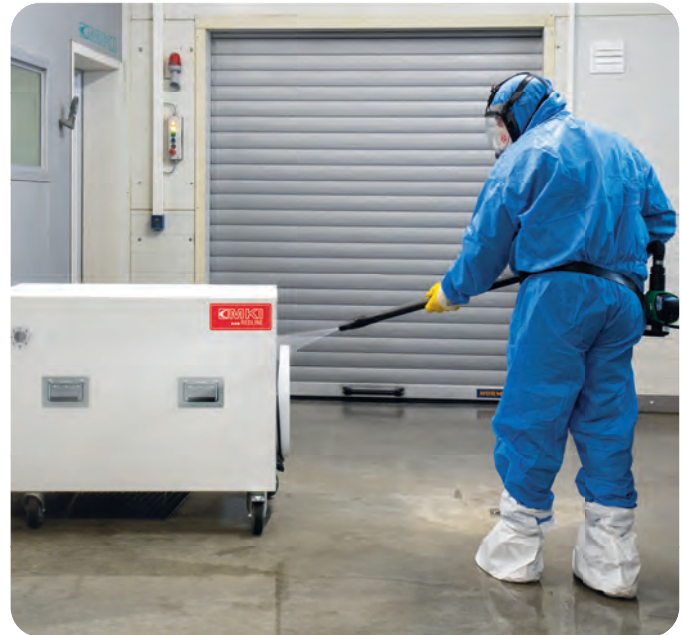
Dekontaminierung im betriebseigenen Schwarzbereich nach TRGS 519-8.2 (8)
